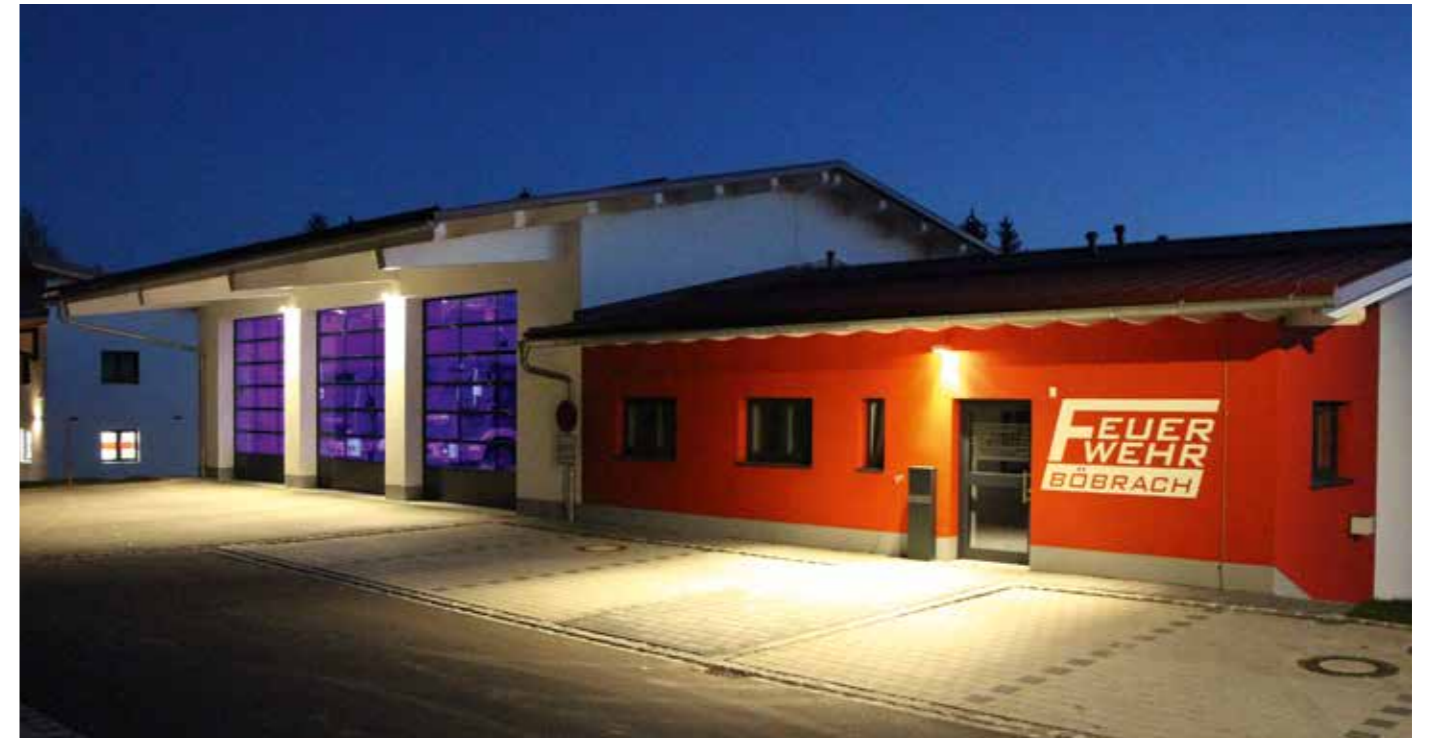
Neues Feuerwehrhaus Böbrach
